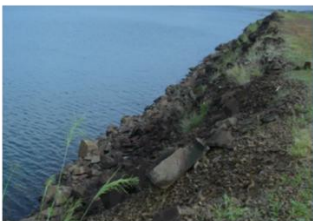
a) Protección con rip-rap
