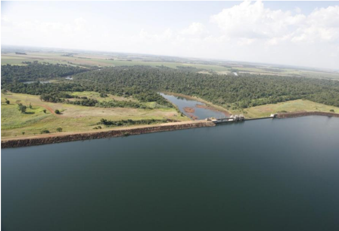
Imagen 4. Vista aérea Presa Yguazú
