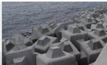
b) Protección con elementos prefabricados de hormigón
